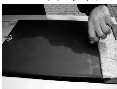
Demontaż wyczystki górnej (3)
