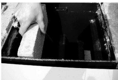
Demontaż wyczystki górnej (5)
