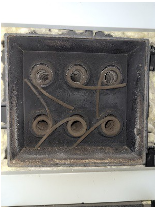
Rysunek 6 Komora wymiennika i zawirowywacze
