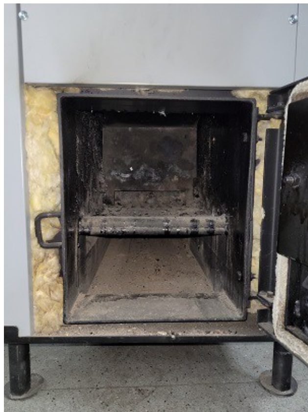
Rysunek 9 Komora paleniskowo-popielnikowa
