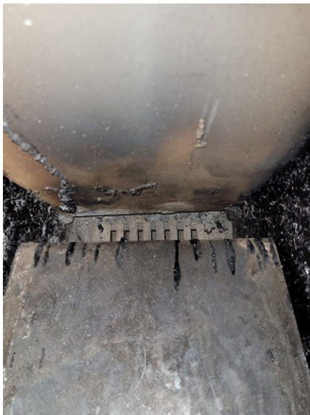
Rysunek 10 Ruszt żeliwny i elementy ceramiczne
