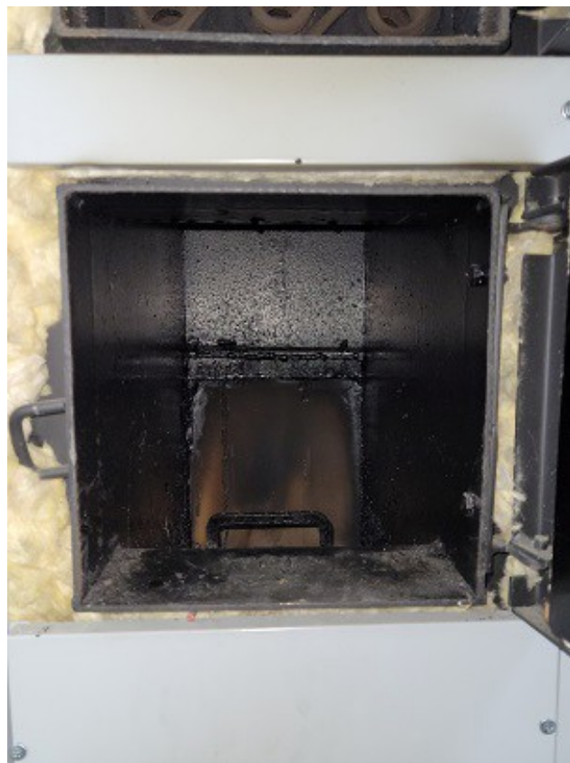
Rysunek 7 Komora załadunkowa
